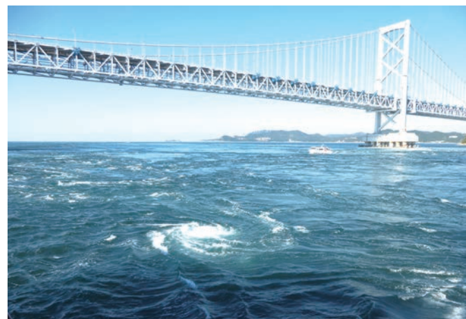
観潮船「日本丸」からみる大鳴門橋の渦潮 (2014)
